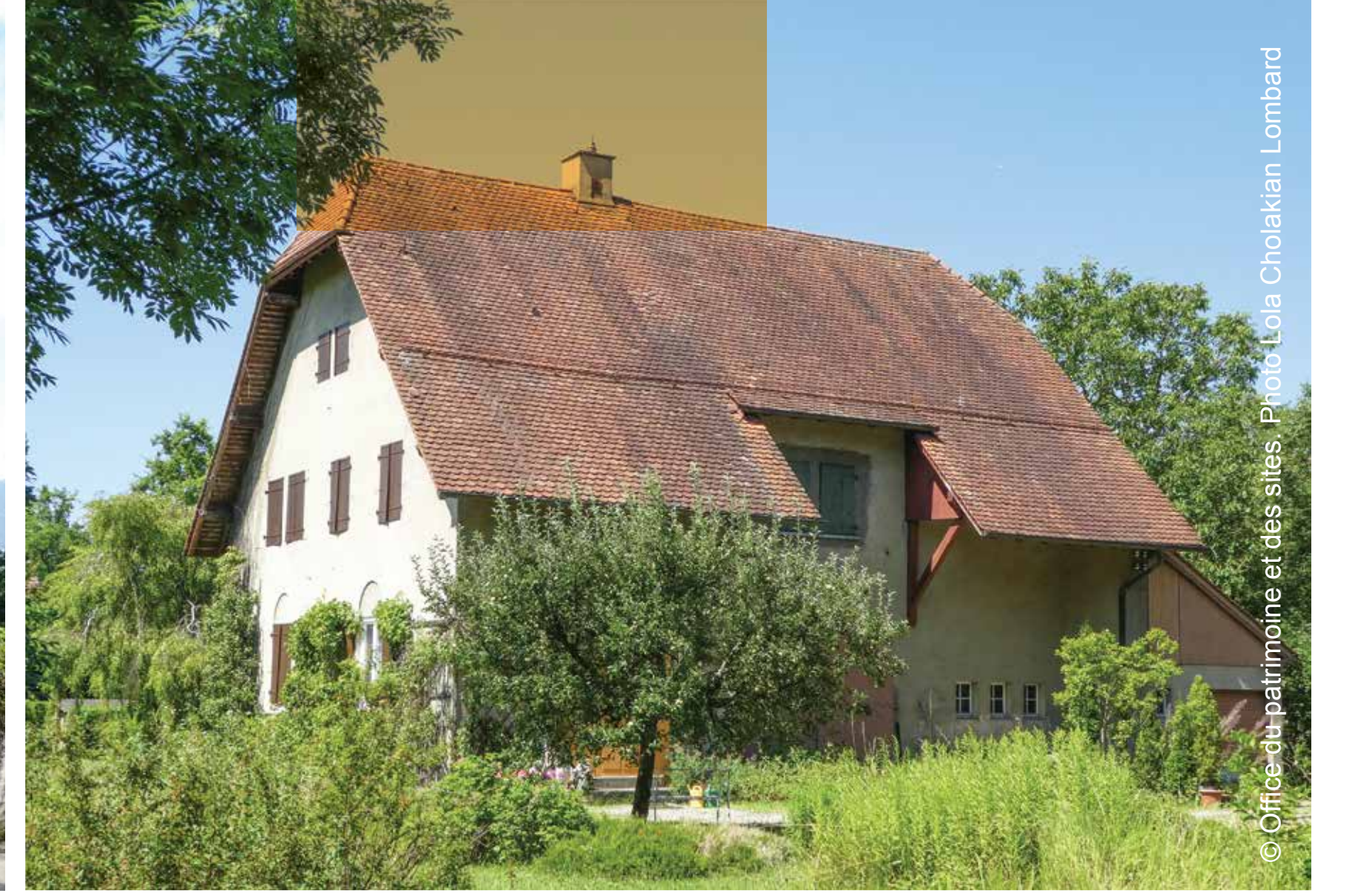
Chemin David-Brolliet 8. Maison rurale. Architecte Maurice Braillard, 1917
