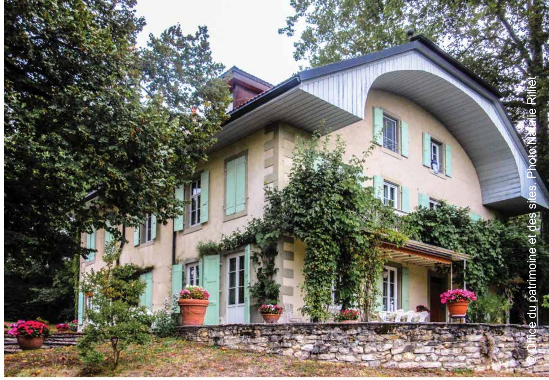
Chemin de Sur-le-Beau 1-3. Domaine de Val-d'Aire. Architecte Marc-François Brolliet (attribution), vers 1835
