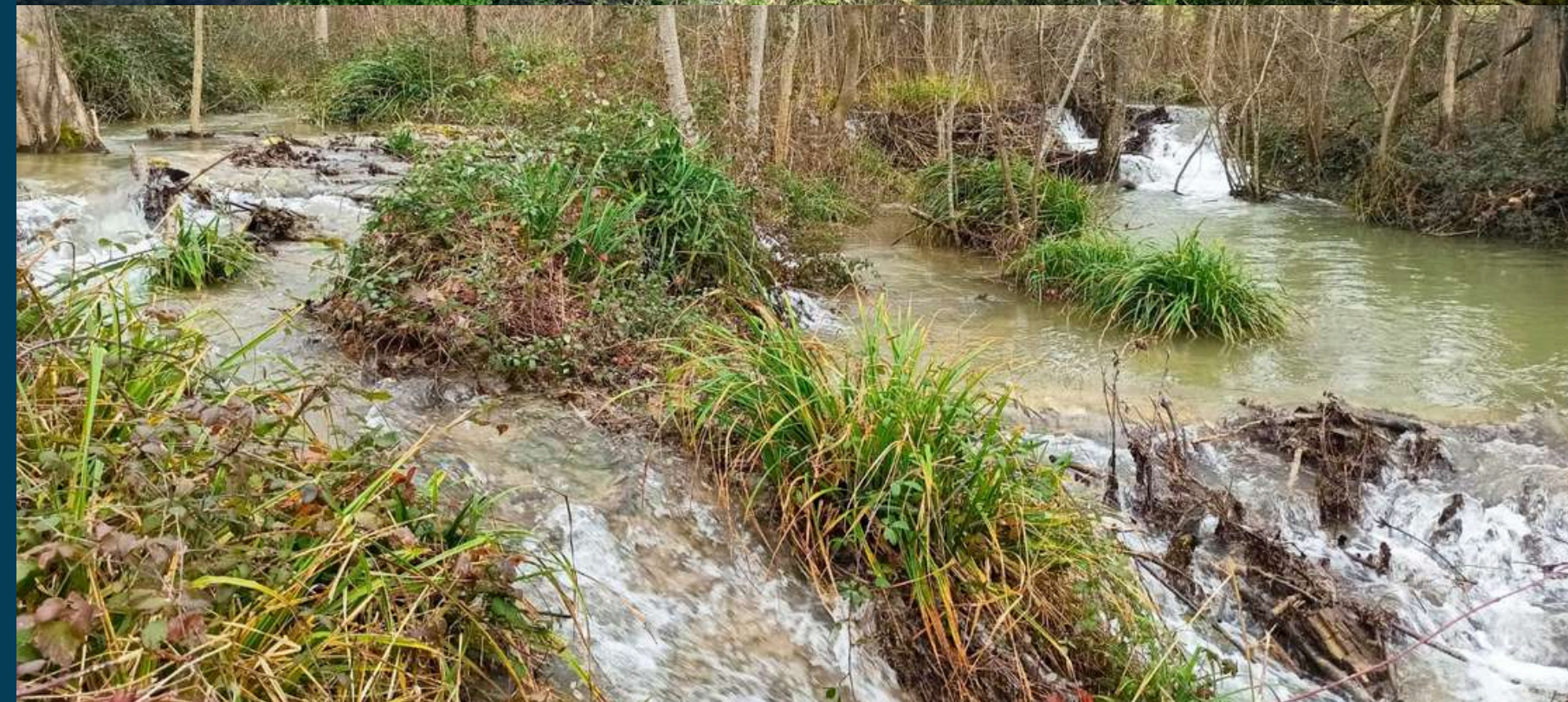
Ouvrages castor-mimétiques construits par les techniciens de rivières formés par le MAPCa et l'ARRA 2 (Drôme)
