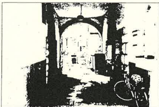
passage sous le bâtiment F490, qui fait la liaison entre la rue Beau-Site et la cour d'entrée devant le bâtiment F488
