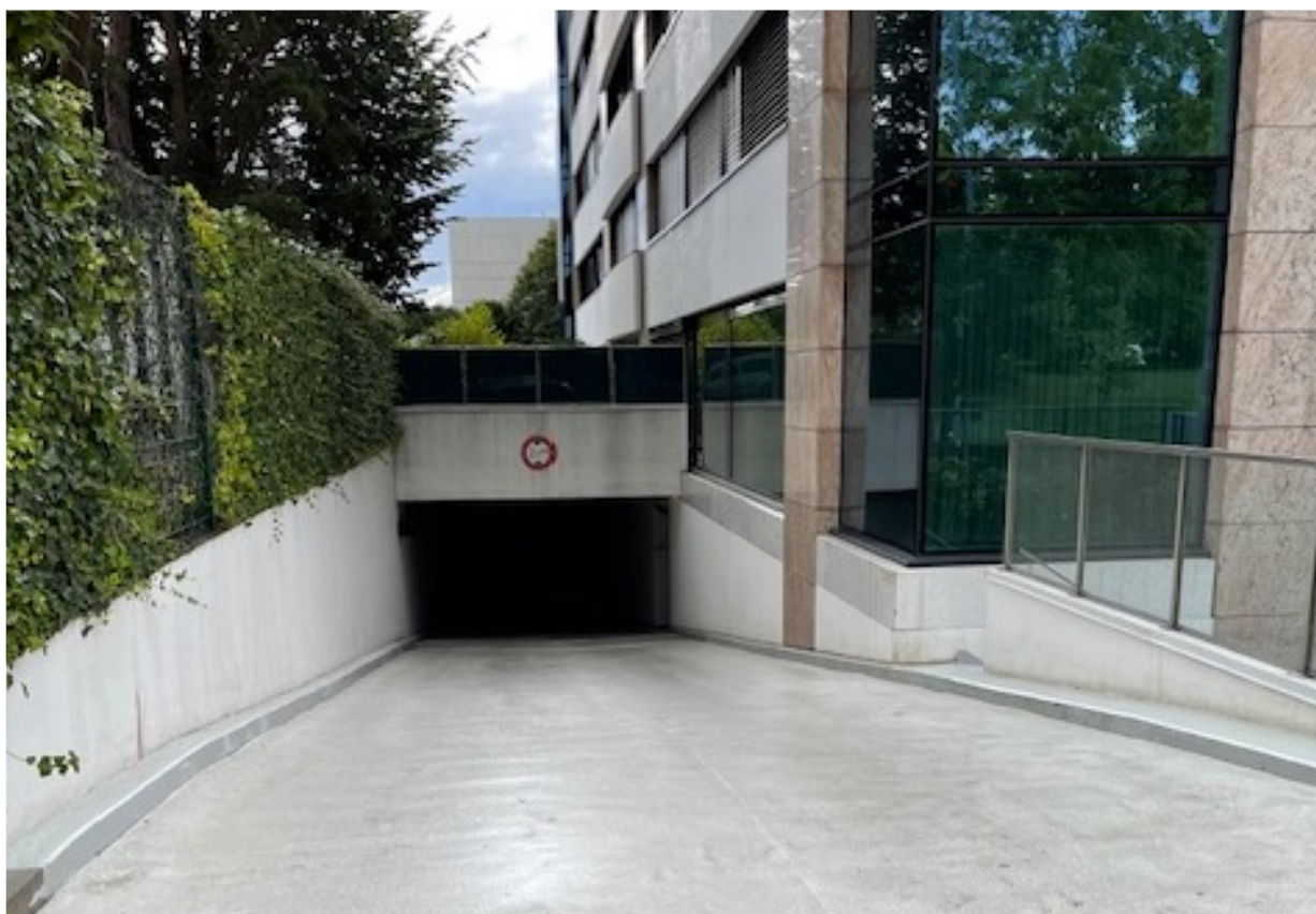
façade ouest, rampe d'accès garage
