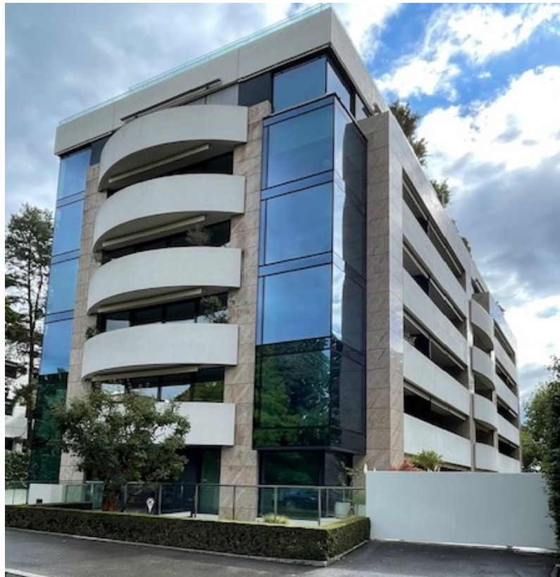
façade ouest sur chemin des Crêts
