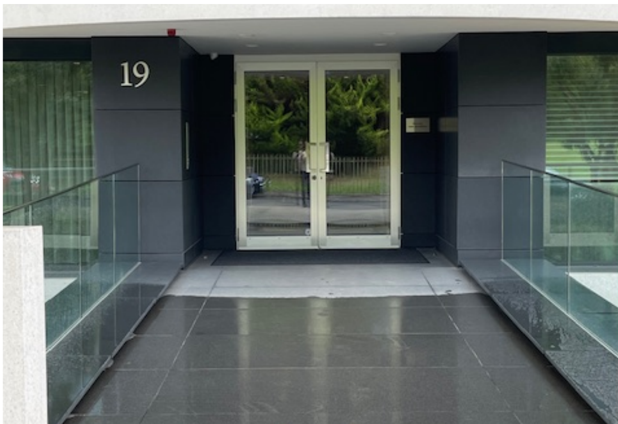
façade ouest, accès principal
