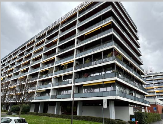
Photo 3: Angle Sud Est
