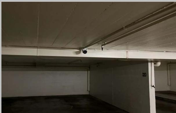
Photo 21: Caméra de contrôle dans le parking
