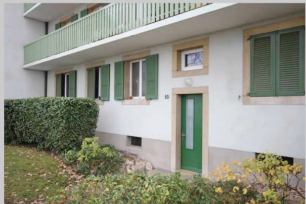
Photo 4: entrée immeuble n° 80
