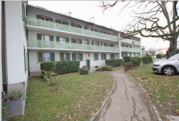
Photo 1: Façade côté route de Chancy
