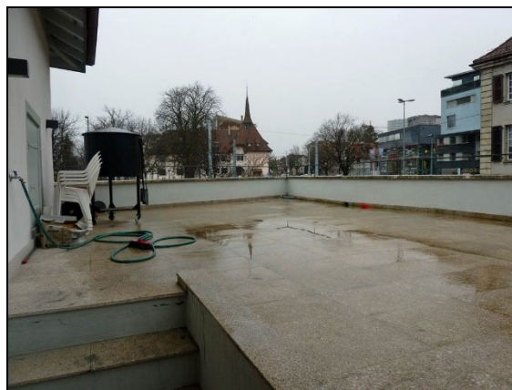
Terrasse privée, côté rue de Genève
