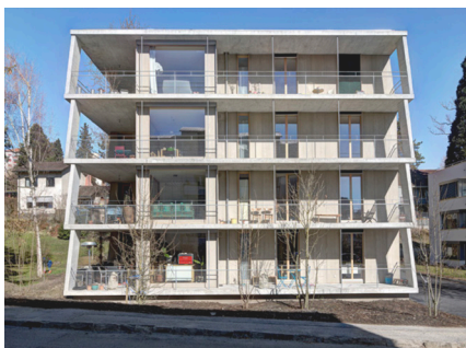
Immeuble d'habitation à Fribourg - 0815 Architekten, 2013 Crédit photographique : H. Schaerer
