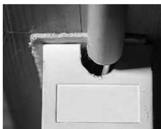
CARTON AMIANTÉ DERRIÈRE UN LUMINAIRE
