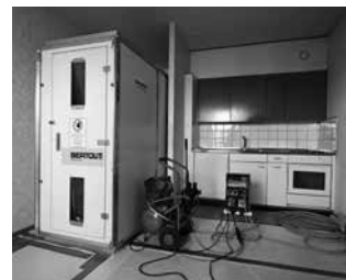
ZONE DE CONFINEMENT (VUE INTÉRIEURE ET EXTÉRIEURE)
