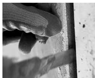
DÉPOSE MINUTIEUSE AU CUTTER
