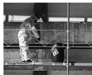
PROTECTION DE L'OPÉRATEUR ET RÉCUPÉRATION DES DÉCHETS
