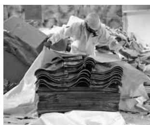
DÉPOSE DE FIBROCIMENT
