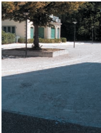
Voie d'accès (zone 3) : les couches bitumeuses ont été remplacées par deux couches de grave et de finition, afin d'obtenir un aspect de «terre-battue».
