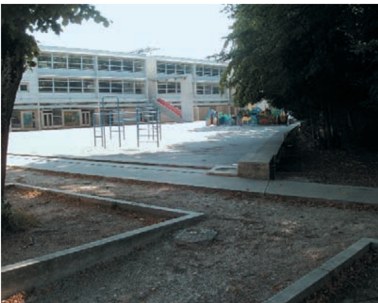
Préau (zone 2) : revêtement double en enrobés bitumeux drainants perméables.
