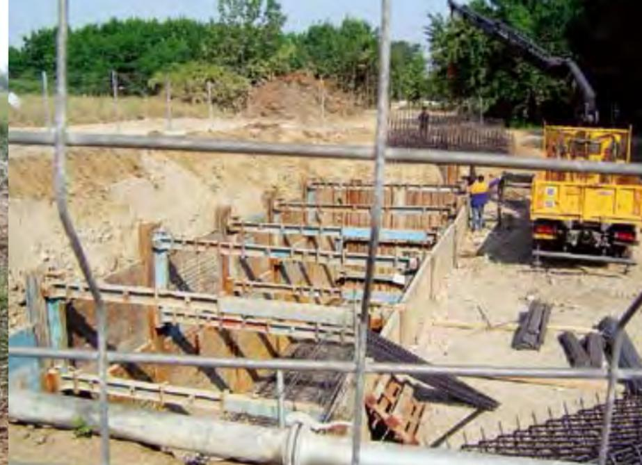
*Page de gauche : travaux d'assainissement : mise en réseau séparatif à Cornières couplée à la réalisation d'un bassin de rétention des eaux pluviales.*
