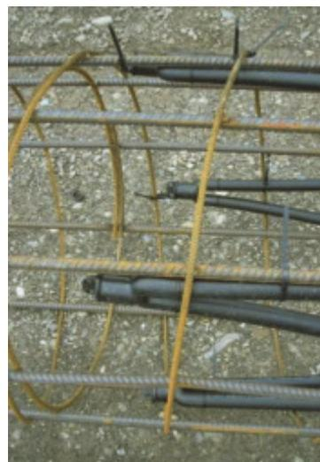
**Figures 6-18 et 6-19. Halle CICR à Satigny. Cages d'armatures de 20 m équipées des sondes en double-U en attente (photo Haka Gerodur)**
