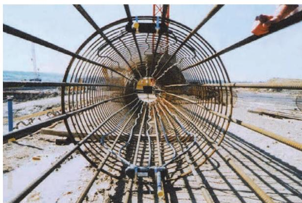
**Figure 6-4. Conduites de circulation de fluide caloporteur fixées à la cage d'armature d'un pieu moulé (photo F-D. Vuataz, CREGE).**
