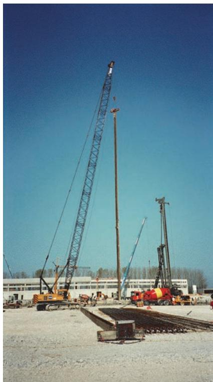
**Figure 6-15 . Pose de la cage d'armature d'un pieu énergétique de 34 mètres de long sur le chantier Aldi à Domdidier (photo J. Wilhelm, 2007).**
