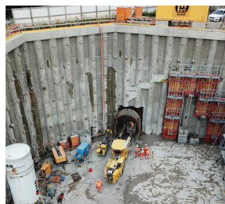
Démarrage de la creuse des galeries de piédroits
