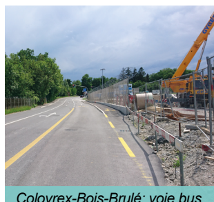
Colovrex-Bois-Brûlé: voie bus
