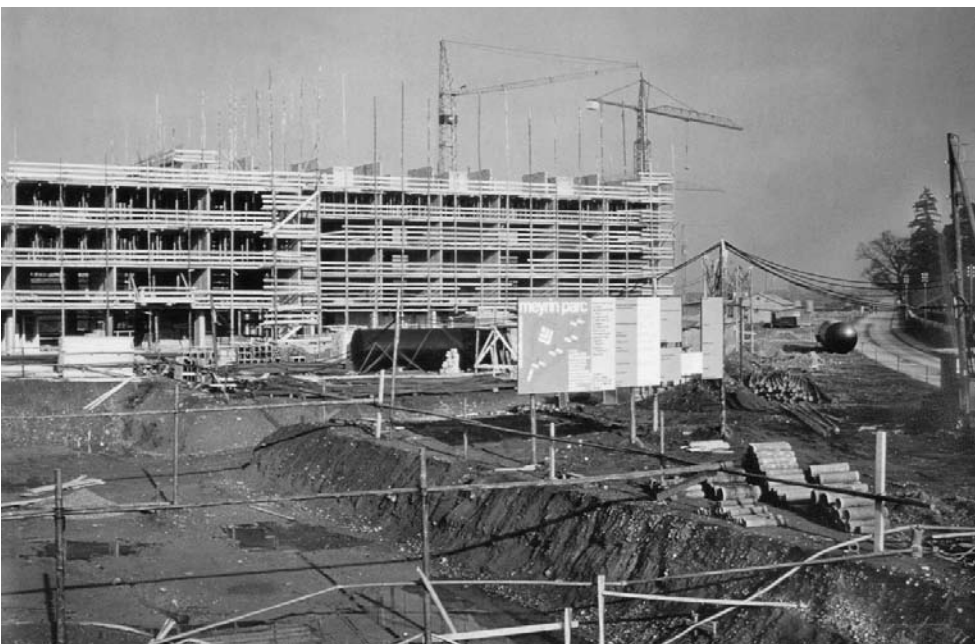
Chantier, vers 1962 ; Archives historiques de la Commune de Meyrin (AHVM)
