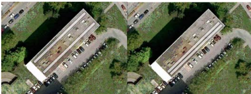
Intégration de panneaux solaire en toiture
