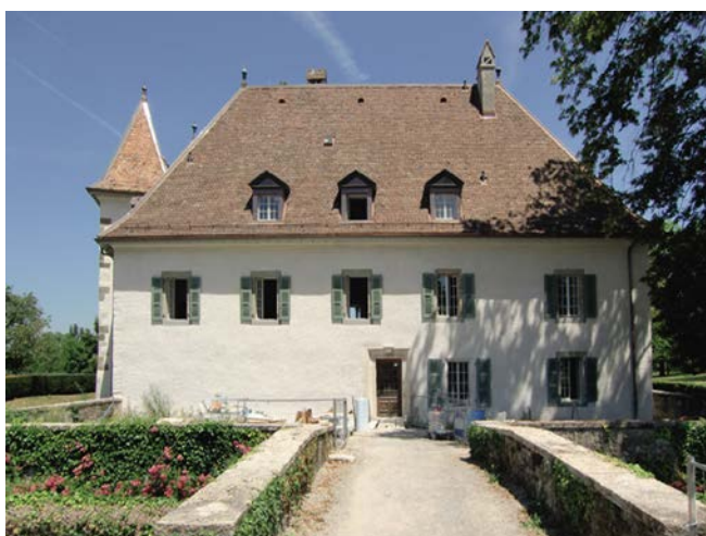
Bâtiment classé , Château de Tournay - Pregny-Chambesey
