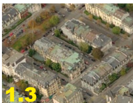
Tranchées des rangées sur rues
