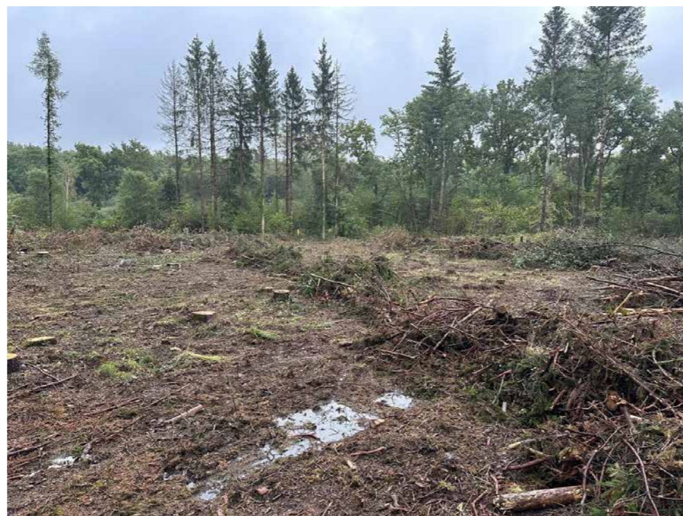
Emplacement d'une des futures clairières après les travaux d'abattage et de débroussaillage.
