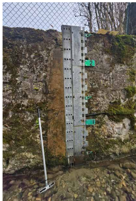
Nettoyage d'une échelle limnimétrique
