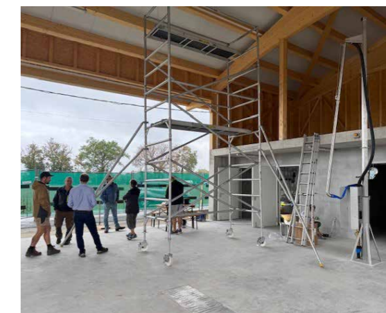
Place de lavage d'Eaumorte
