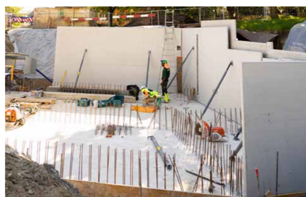
Rénovation du parc des Franchises
