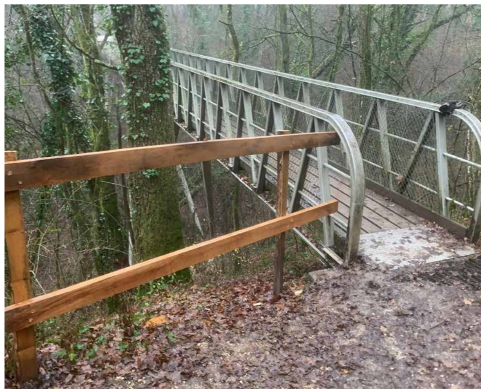
Au fil du Nant d'Avril, une passerelle remise à neuf
