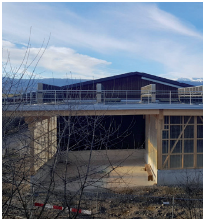
Place de lavage et remplissage collective de Soral en chantier, janvier 2025
