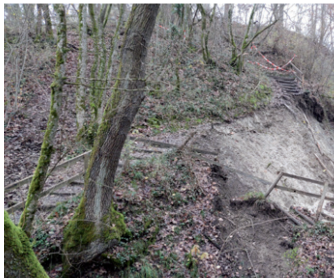
Effondrement du chemin
