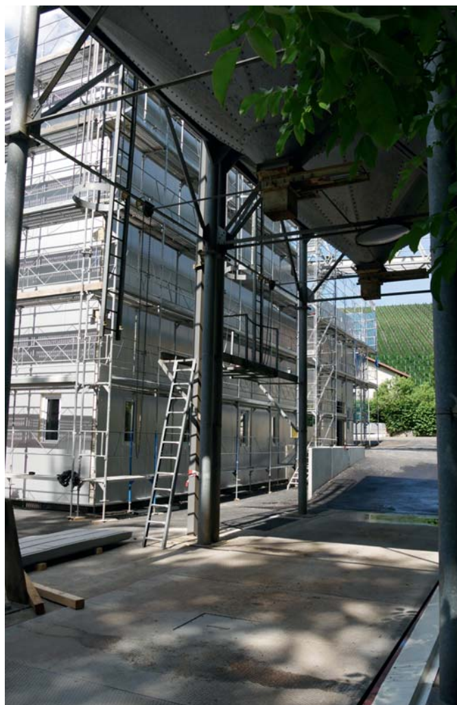
Construction du nouveau bâtiment du Moulin de la Plaine
