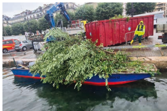
Evacuation des ligneux des enrochements - Perle du Lac
