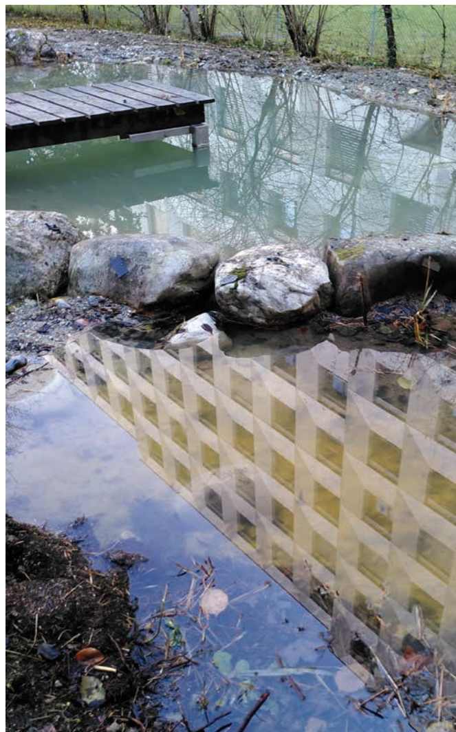
L'étang pédagogique du Collège Rousseau à la fin des travaux de renaturation
