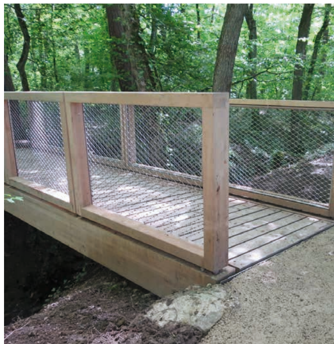
Passerelle du Bois des Pins - Veyrier
