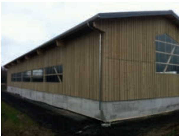
Construction d'un hangar agri-viticole à Lully.
