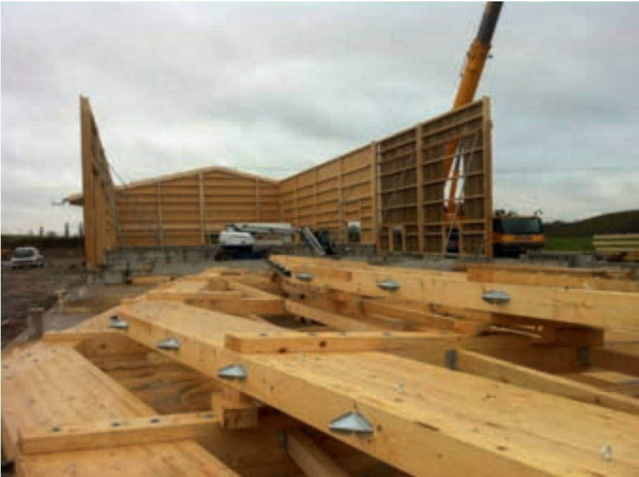
Montage du hangar collectif de Sorat.
