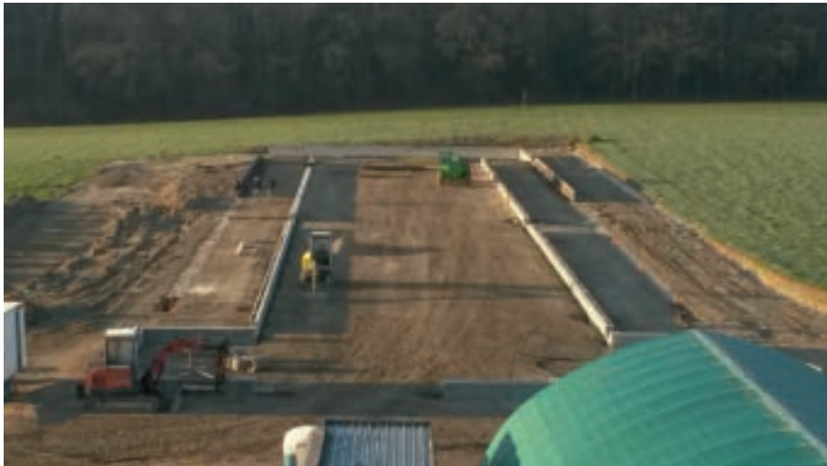
Construction d'un poulailler pour 12'000 pondeuses à Céligny.
