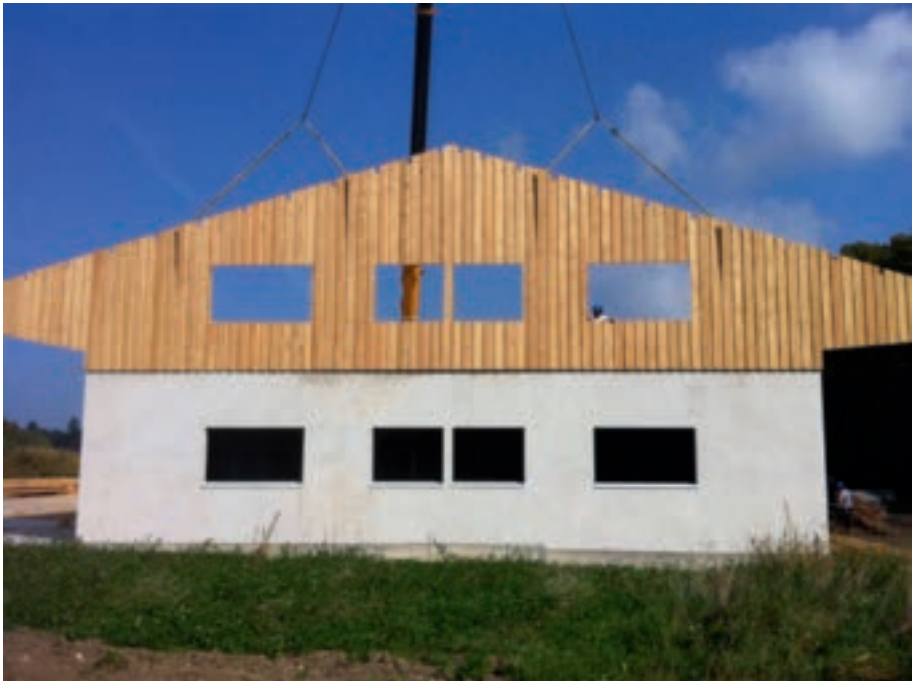
Construction d'un hangar agri-viticole à Vandoeuvres.
