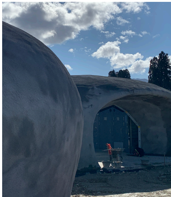
Construction de deux édifices (mars 2020) © Etat de Genève
