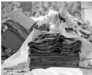
DÉPOSE DE FIBROCIMENT
