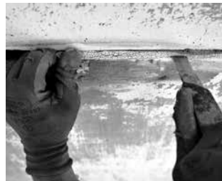
RETRAIT DE JOINT PCB AVEC CUTTER
