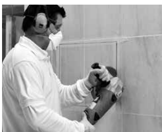
OUVERTURE D'UNE CLOISON
