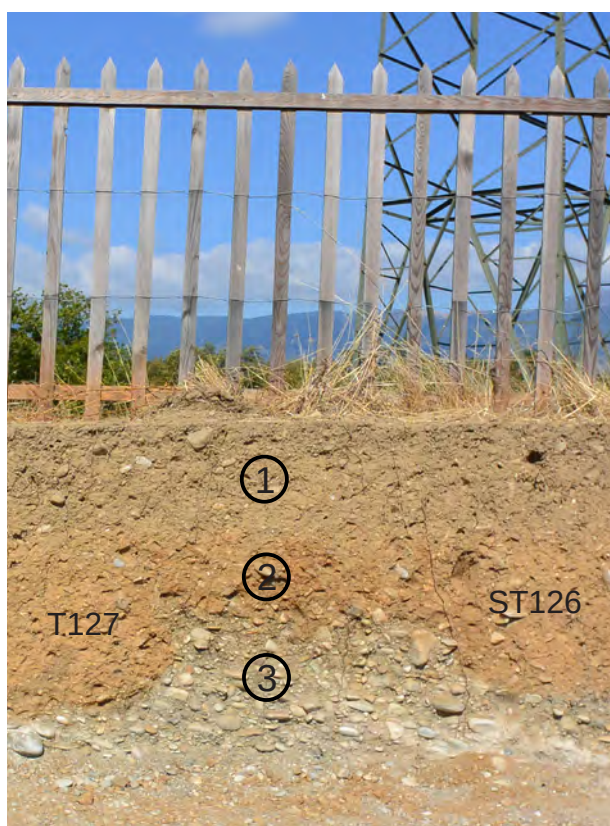
Figure 53. Une portion de stratigraphie entre T127 et ST126 dans laquelle on distingue 3 couches.
