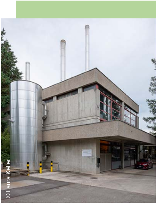
Nouvelle chaufferie à bois de l'HEPIA Lullier
