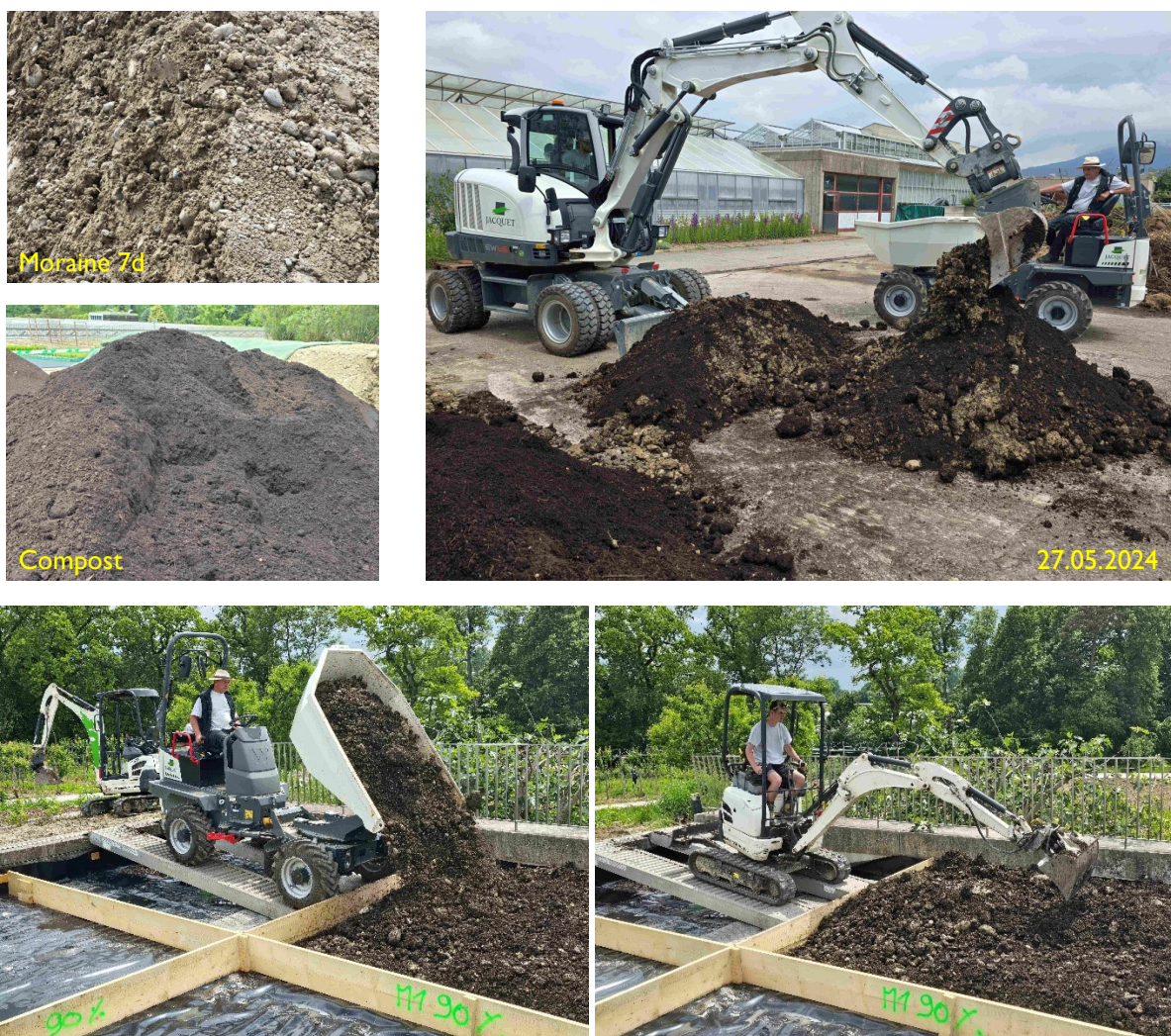
Figure 3 : Travaux de mise en œuvre des placettes expérimental sur l'espace « Toitures végétalisées » de Lullier
