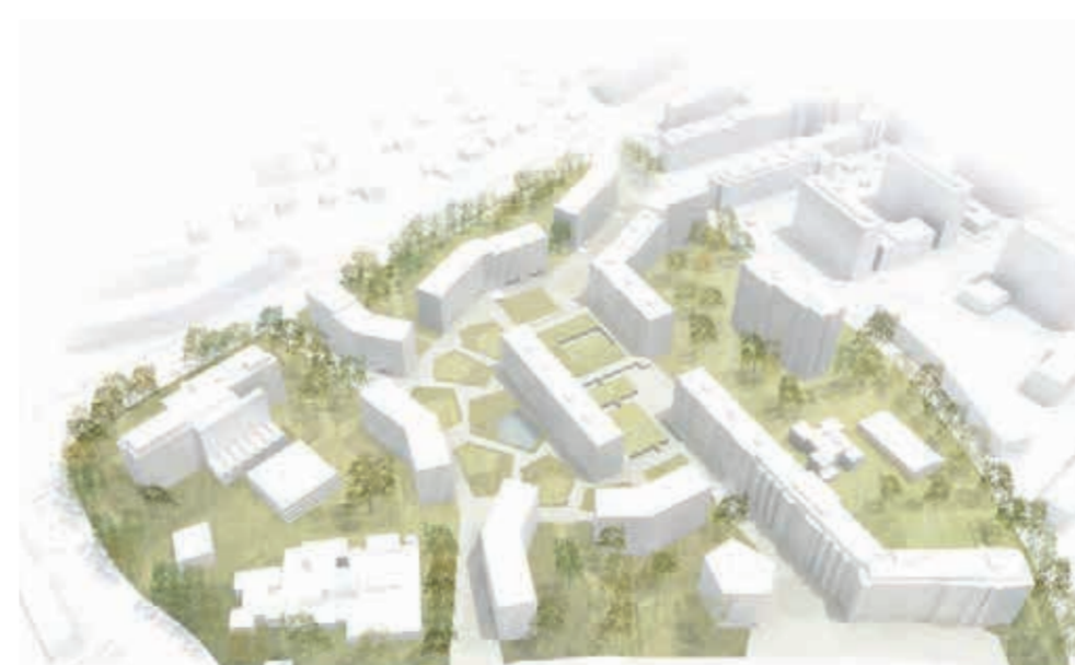
Le projet Papillon – quartier Vieuxseux – transforme progressivement le périmètre Vieuxseux-Villars-Franchises dans une logique de rénovation et de densification douce. Porté par la SCHG, il associe logements, espaces partagés et aménagements paysagers dans une vision durable et intergénérationnelle du quartier. © Jordi Rodríguez Architectes, 2012
