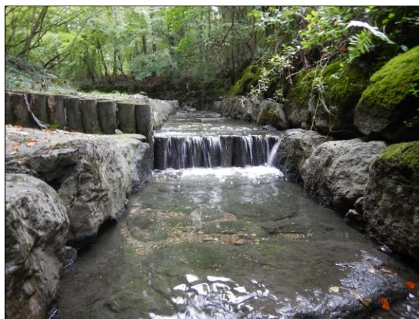
Photo 13 : Seuil infranchissable situé à la limite amont de la station de pêche électrique
