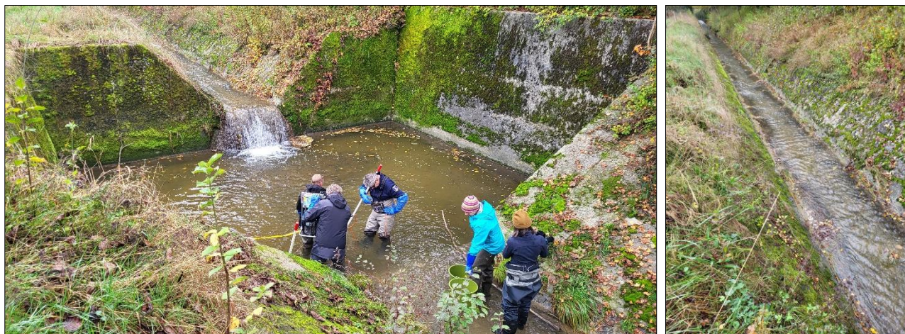
Photos 10 et 11 : La station du Nant de Goy en amont du carrefour d'Aire-la-Ville
