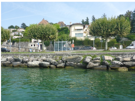
Station N° 10 – Quai de Cologny
