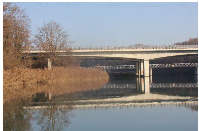
Conditions lenticques en aval du pont de l'autoroute
