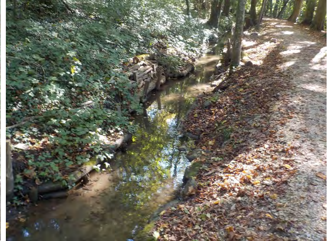
L'aménagement des sous-berges et déflecteurs fournit des abris à la faune piscicole, principalement aux truites.
