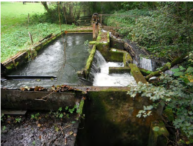
Système de dévalaison à l'extrémité aval du Bief de la Vieille Bâtie
