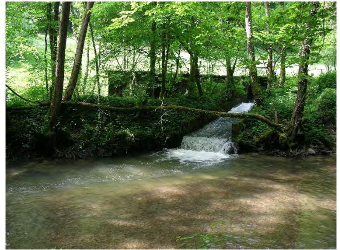
Exutoire du système de dévalaison dans la Versoix (secteur à débit résiduel)
