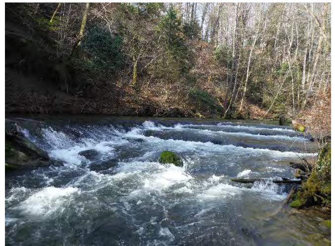
Aménagement migratoire à la prise d'eau du Bief de la Vieille-Bâtie
