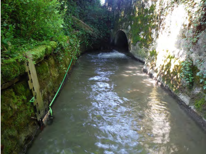
Au passage sous la route de Suisse, la migration piscicole (truite lacustre principalement) est sensiblement entravée mais reste possible.
