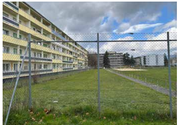
Le stade de Vaudagne, en cours de réhabilitation
