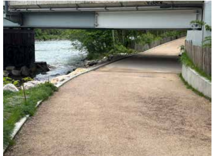
Passage sous la route de la Fontenette
