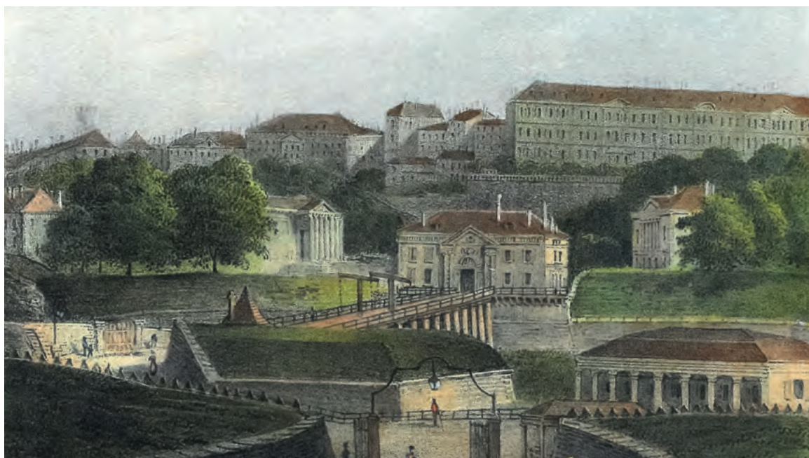
Fig. 14 Estampe de J. Du Bois montrant l'accès à la Porte Neuve par un pont, vers 1840.
