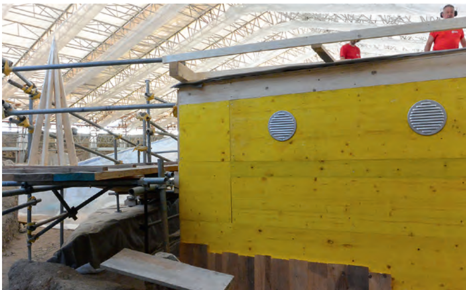
Fig. 10 Coffrage de bois destiné à protéger le vide sanitaire appartenant à la maison romaine mise au jour sur l'esplanade Saint-Antoine.
