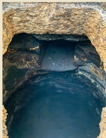
8 Le puits de la rue de Beaumont 14. Vue de la dalle de couverture en calcaire avec son couvercle (a) et du cuvelage avec la canalisation d'adduction d'eau (b). Photo SAGe.
