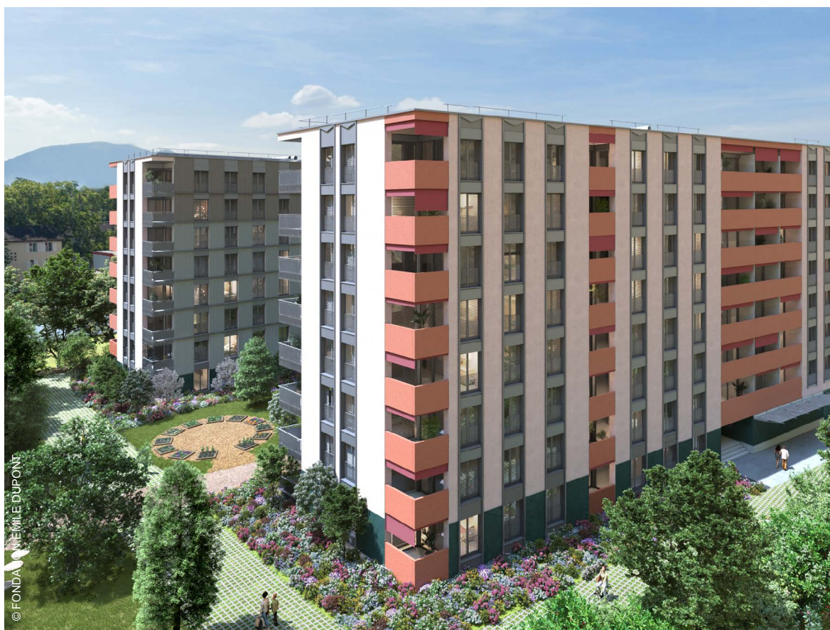
Route de Vernier 110D / FONDATION EMILE DUPONT 1219 Châtelaine
