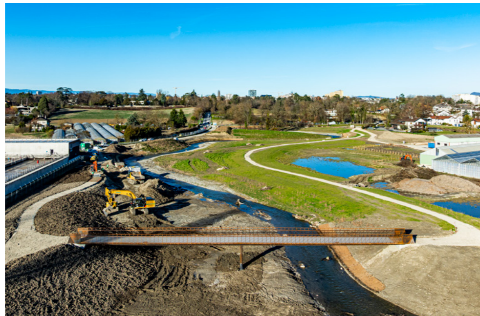
Passerelle sur le Foron
