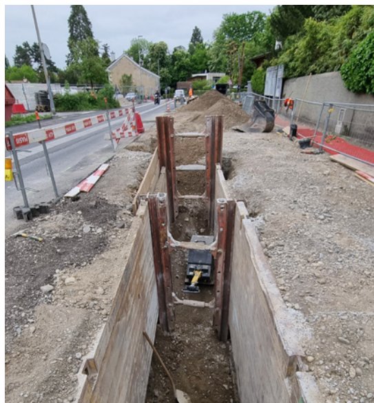
Chantier public chemin de la Montagne
