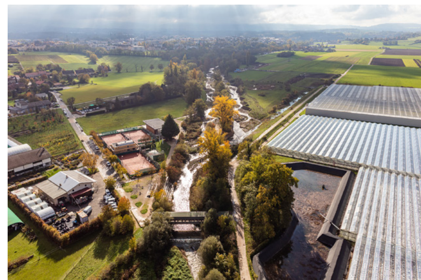
Renaturation de l'Aire à Perly-Certoux
