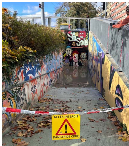
Fermeture d'un passage sous voie
