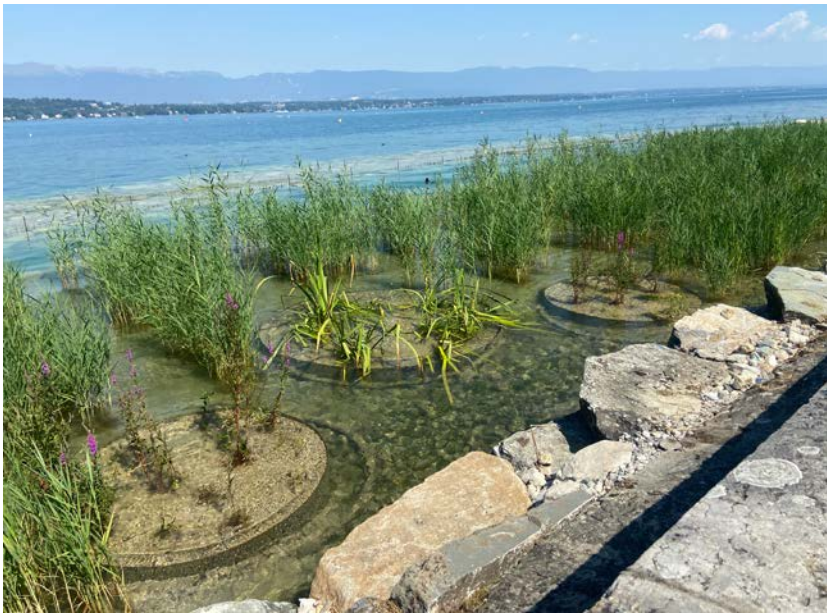
Roselière de 5000 m 2 sur le quai de Cologny
