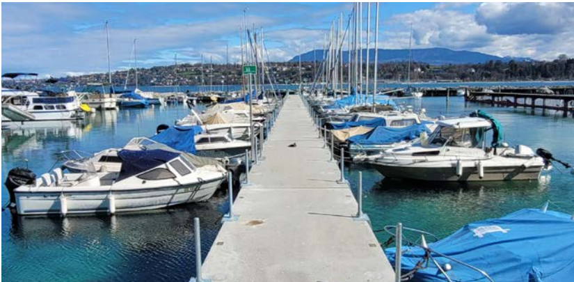
Nouvelle estacade au Port-Wilson
