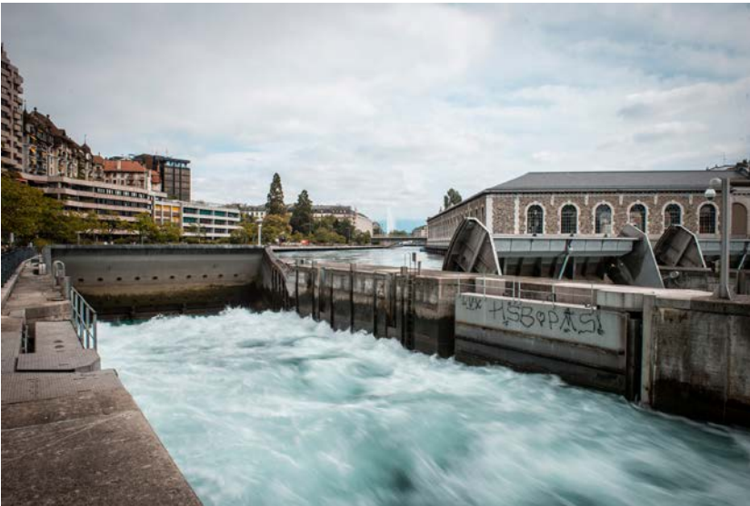
Barrage du Seujet
