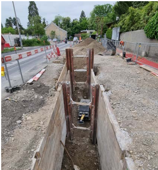
Chantier public chemin de la Montagne
