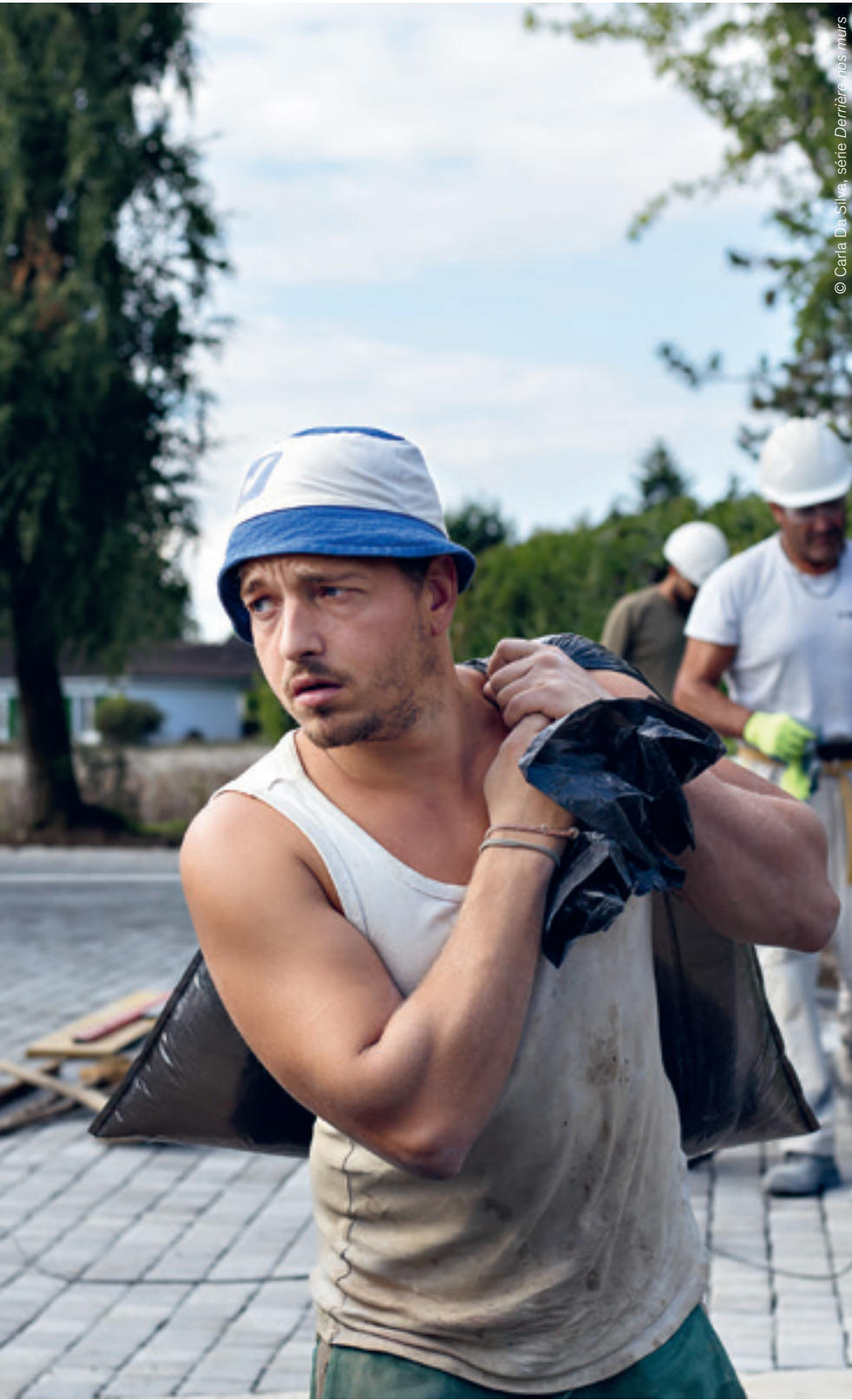
Genève, années 2020 : un maçon sur un chantier. Charge, gestes et travail d'équipe, un quotidien du bâtiment marqué par l'effort et la solidarité.
