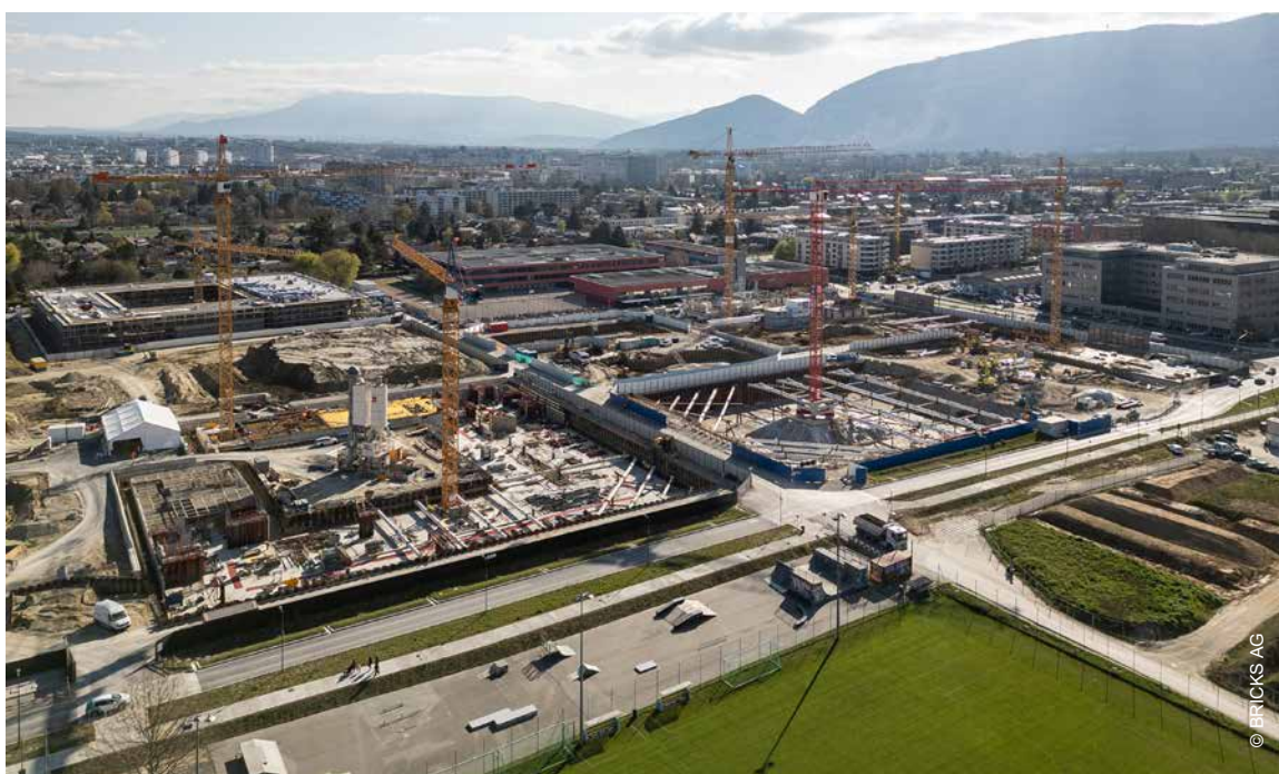
Chantier du Rolliet à Plan-les-Ouates
