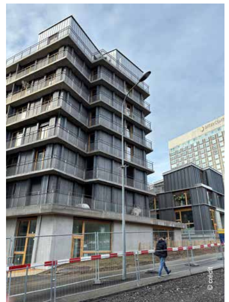
PLQ Sous-bois et TNGS en chantier
