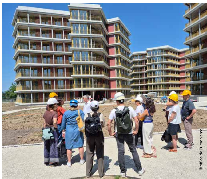
Fin de chantier « Messicoles » aux Grands Esserts
