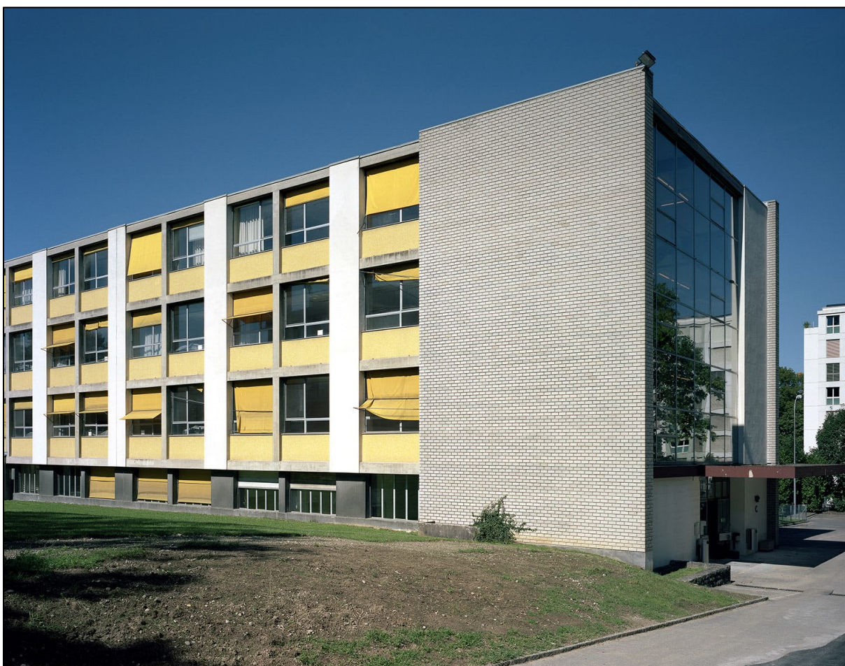
La façade en maçonnerie et le pignon vitré du bâtiment C, 2010. Photo : © Office du patrimoine et des sites, Claudio Merlini
