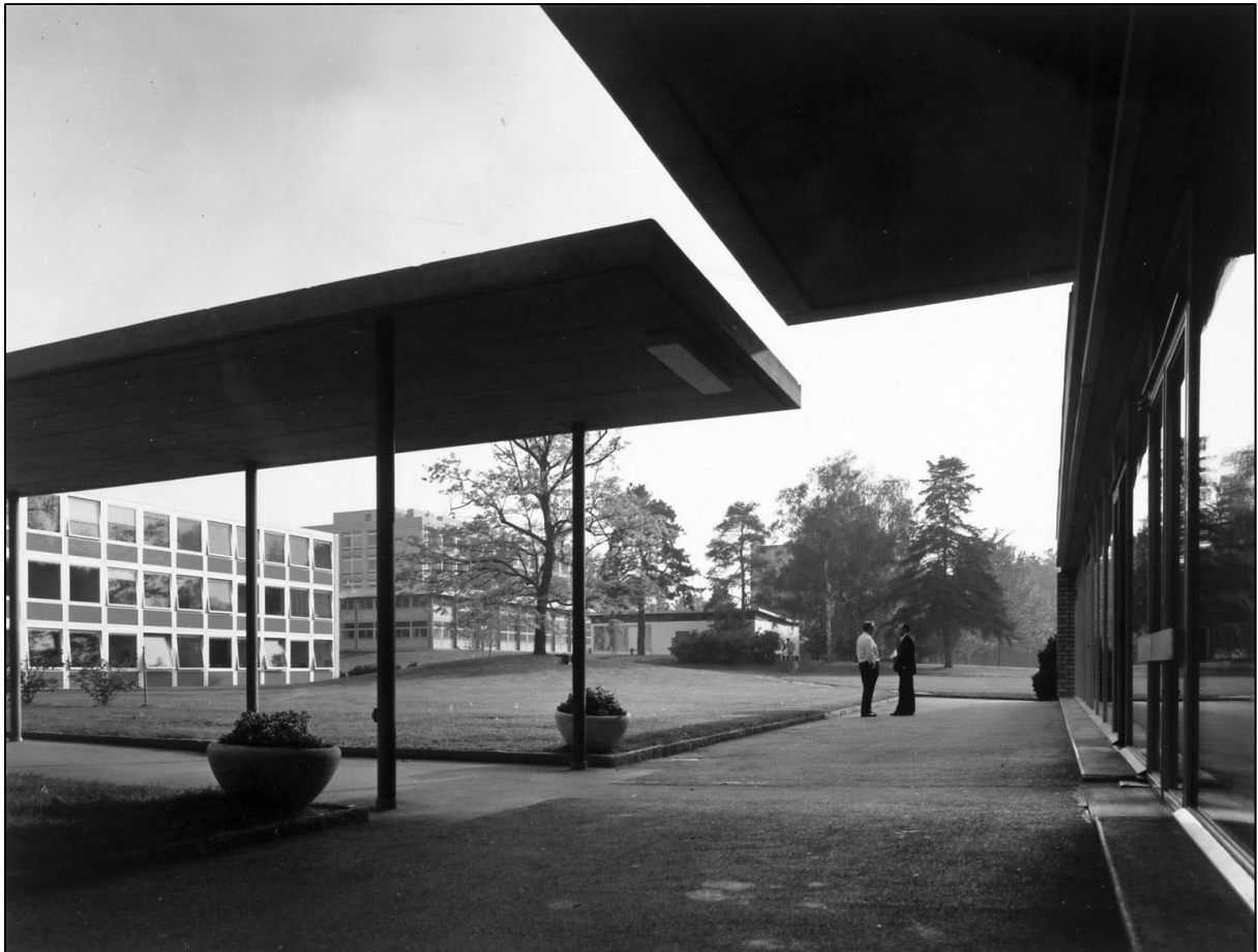
L'élégant couvert en béton reliant les bâtiments A (à droite) et D (à gauche). On distingue au fond de l'image le bâtiment F. Archives Battelle Genève
