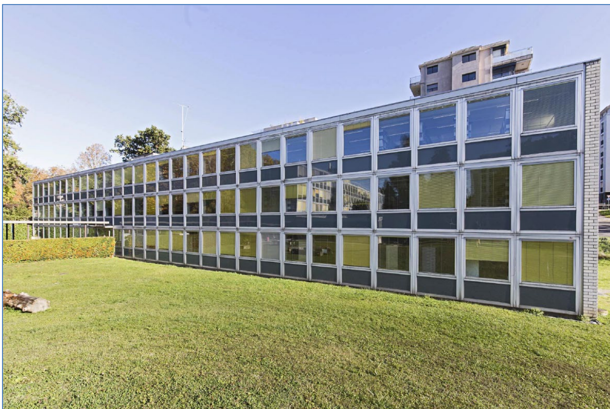
La façade en mur-rideau du bâtiment D, 2021. Photo : GSK- SHAS © Michael Peuckert
