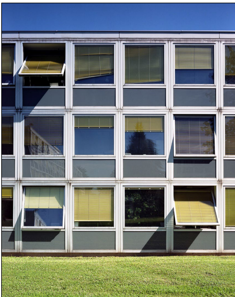
Détail de la façade du bâtiment D avec ses fenêtres basculantes de type « Carda », 2010. Photo : © Office du patrimoine et des sites, Claudio Merlini.
