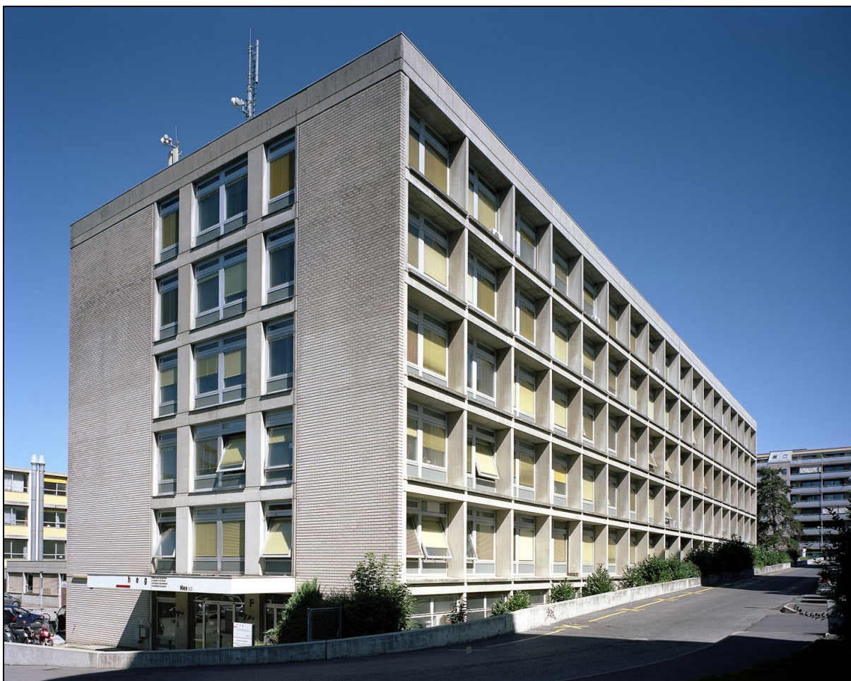
Le bâtiment F dévoilant l'une de ses façades-grilles en béton, 2010. Photo : © Office du patrimoine et des sites, Claudio Merlini
