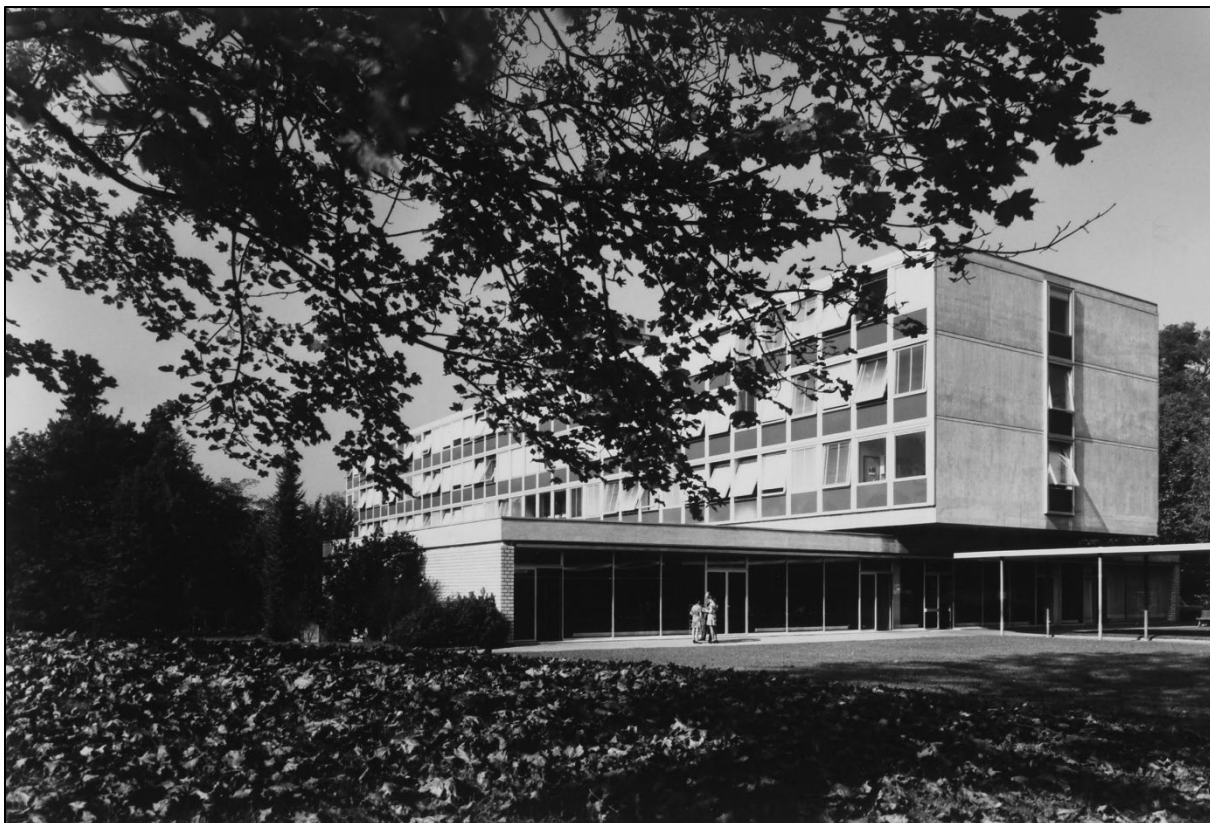
Le bâtiment A : le volume bas de la cafétéria glisse sous le prisme vitré des laboratoires et des bureaux placés en léger porte-à-faux. Archives Battelle Genève
