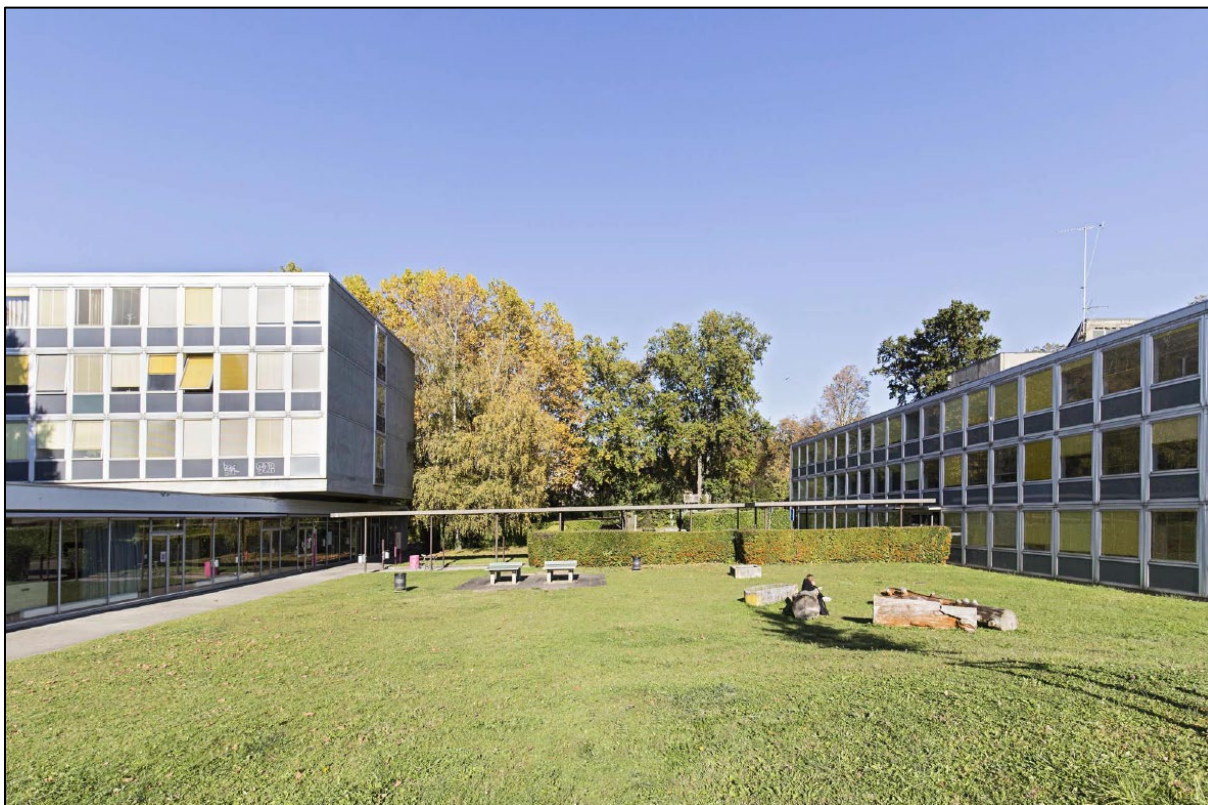
L'espace de verdure entre les bâtiments A et D, 2021. Photo : GSK- SHAS © Michael Peuckert
