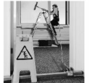
7 Nettoyage des fenêtres. La personne est assurée au moyen d'un antichute à rappel automatique en position horizontale. Le dispositif est fixé à une traverse ancrée dans le châssis de la porte.
