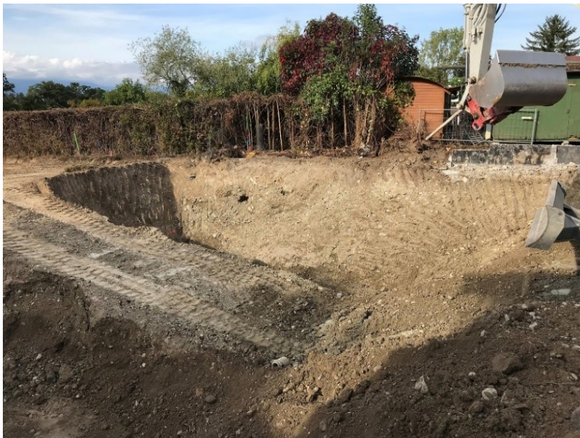
Fig. 4 Terrassement de la zone à bâtir sur 3 à 4 m de profondeur au sud de la parcelle.
