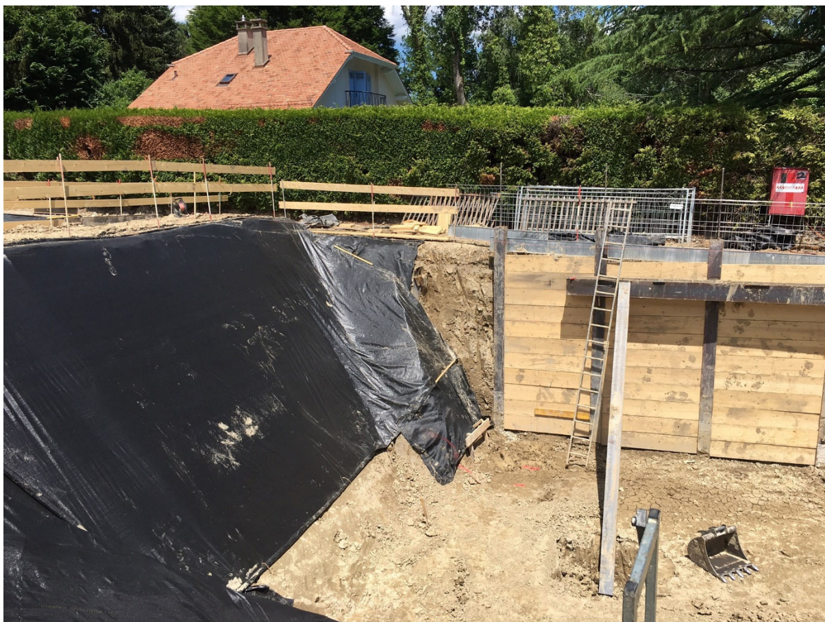
Figure 7. Le terrain naturel argileux apparaissant directement sous la terre végétale a été rapidement étayé par les constructeurs, nous interdisant toute observation détaillée ou extensive des coupes de l'excavation.
