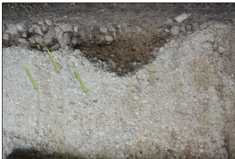
Fig. 18 Détail de la chaussée ST53 : quelques traces d'ornières sont visibles.
