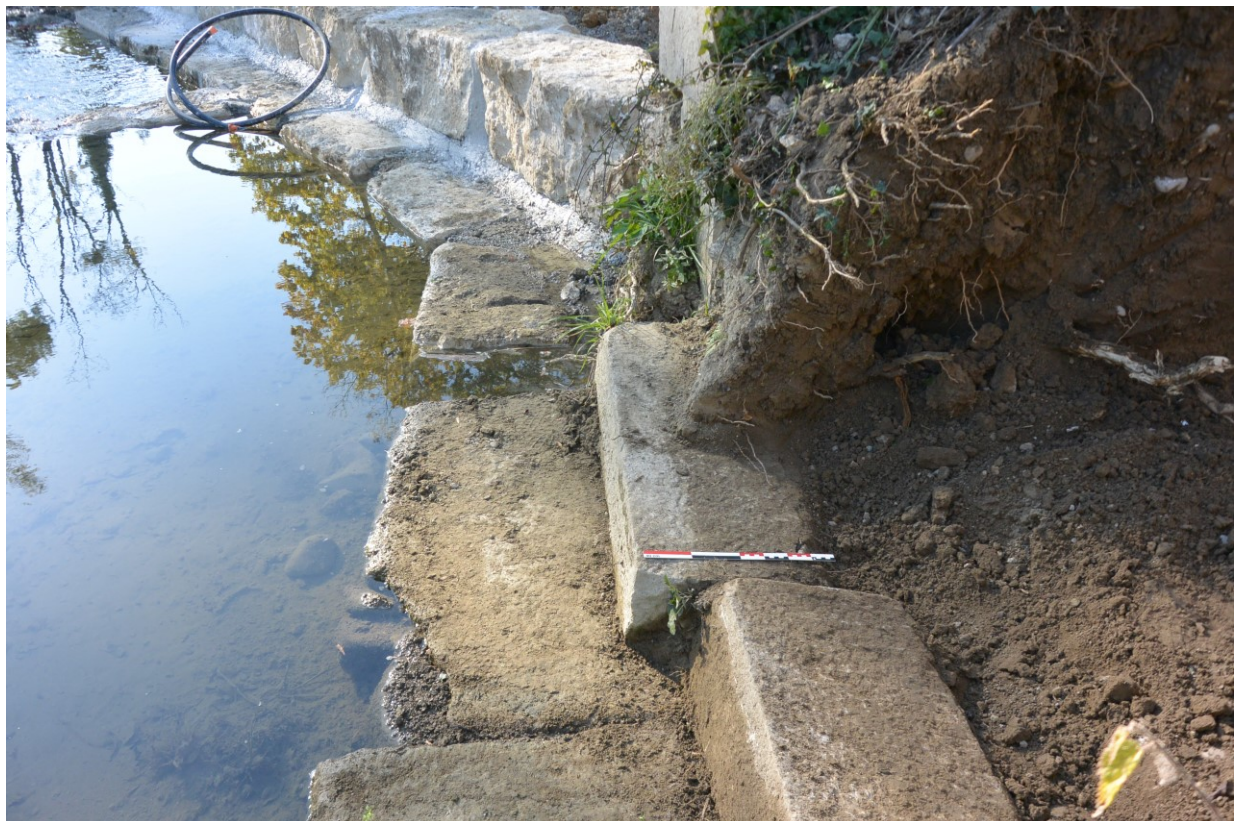
Fig. 16. Une pierre de la bordure du lavoir déplacée par les racines d'un arbre et/ou la poussée des remblais.
