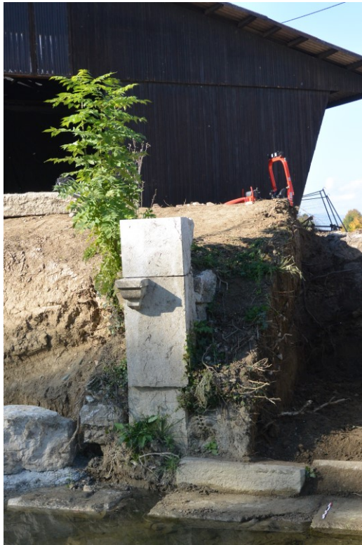
Fig. 14 et 15. Détail des deux piliers du lavoir. Leur état de conservation précaire nécessite une intervention de restauration et remise en place des blocs assez urgente.
