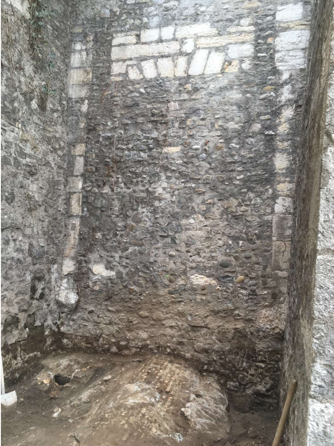
Figure 5 : Large ouverture condamnée, découverte dans le décrochement nord du bastion de Saint-Léger.
