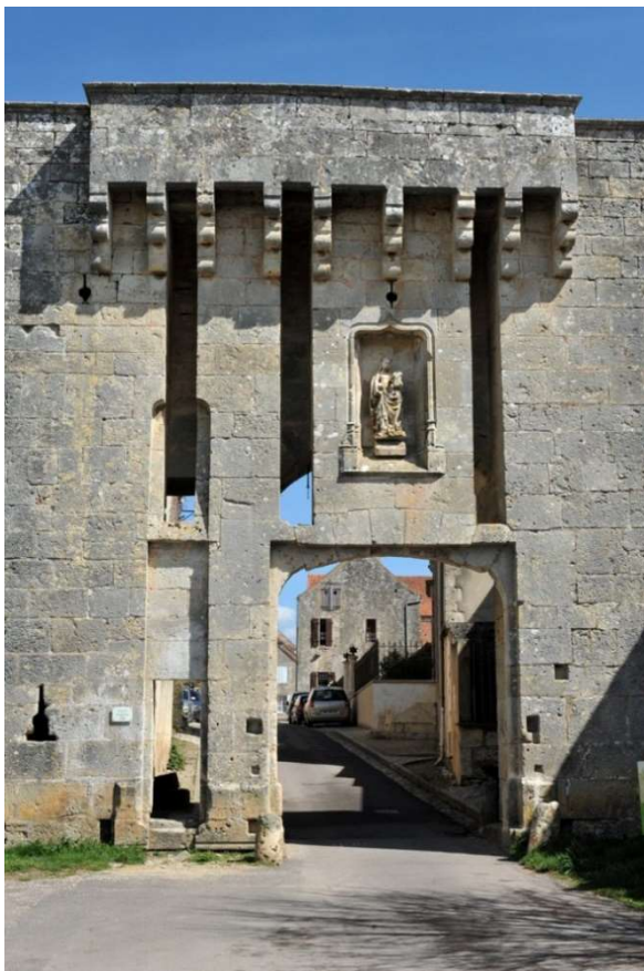
Figure 17 : Porte de Barme à Flavigny-sur-Ozerain (Bourgogne-Franche-Comté), flanquée de sa porte piétonnière. Les ponts-levis ont été démontés; on observe toutefois les trouées des flèches, elles aussi désinstallées. Le couvrement est légèrement arqué sous une plate-bande à claveaux irréguliers. Des mâchicoulis sur consoles ont été aménagés en couronnement du portail. 15 e siècle.
