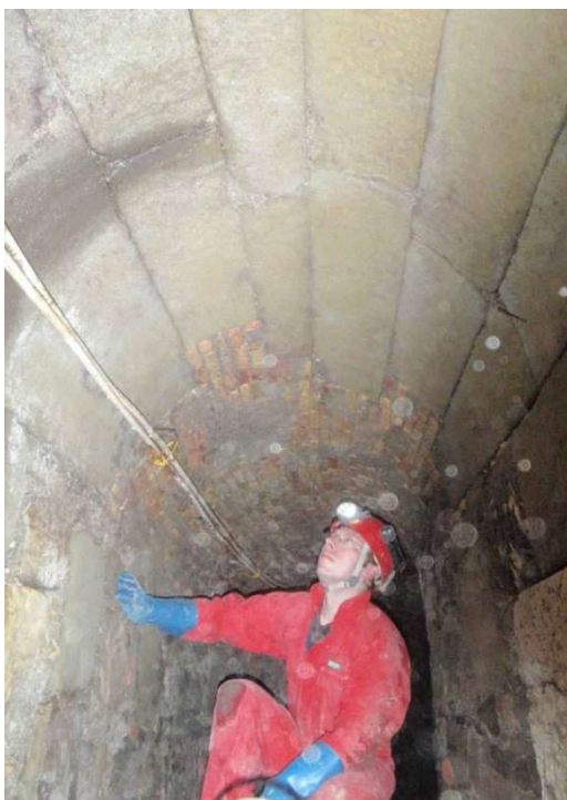
Figure 23 : Tronçon de galerie sous le terre-plein du bastion de Saint-Léger datant probablement de sa construction entre 1537-1539. On remarquera sa couverture en molasse et une partie de ses montants en blocs de calcaire.
