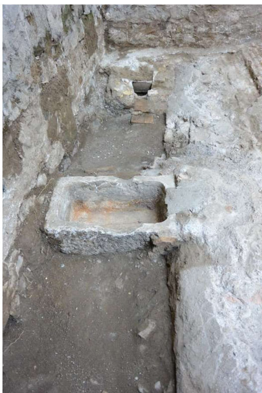
Figure 3 : Assainissement du flanc est du souterrain constitué d'une bouche de récolte d'eaux pluviales et d'un bac de décantation en calcaire, aménagé en aval.
