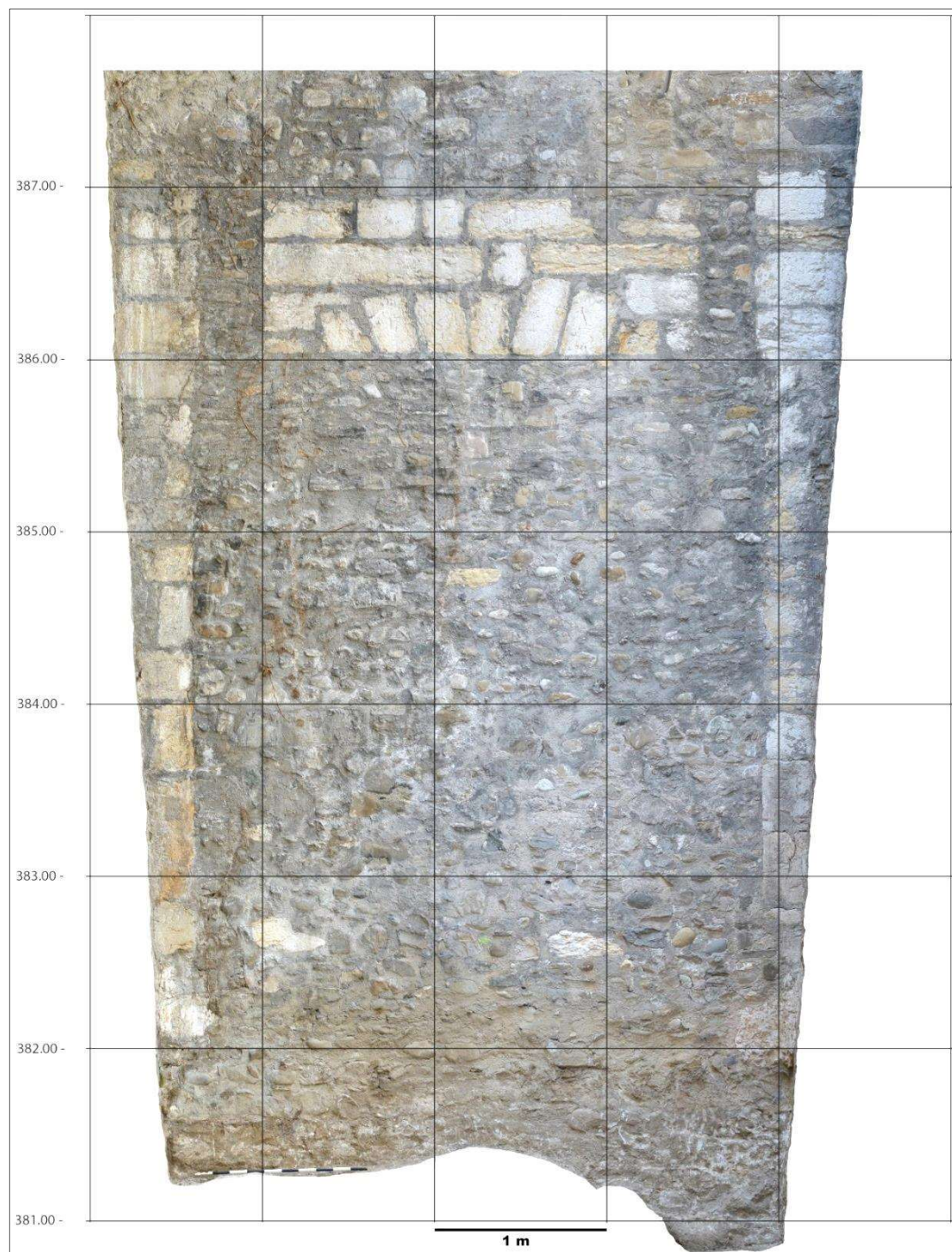
Figure 6 : Photogrammétrie de la poterne avec mensurations et altitudes.
