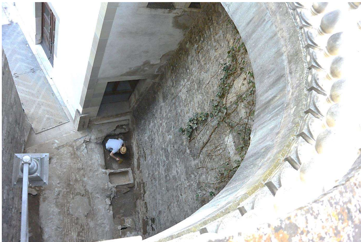
Figure 9 : Sous la balustrade moderne et le lierre à droite, une partie de l'encadrement calcaire d'une ouverture condamnée a été observée.
