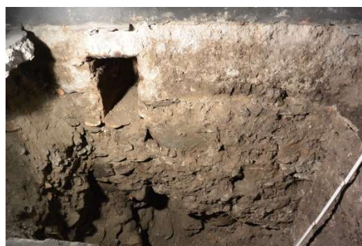
Fig. 8 Canal d'évacuation d'eau rectangulaire dans les fondations du mur ouest du manège actuel.
